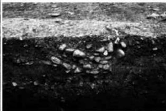
4 礎石据付穴Ⅱ検出状況(南から)
