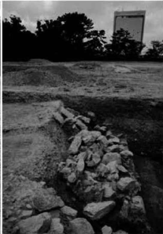
3 本丸東石垣崩落痕跡検出状況(南から)
