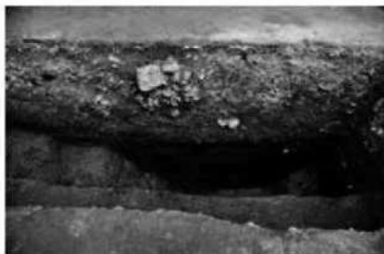
1 SD03 検出状況(西から)
