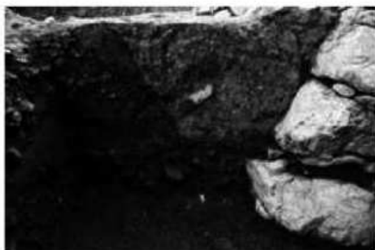
2 石垣隅角部構築状況(北から)
