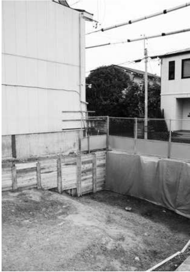
1 調査区1 完掘状況（南西から）
