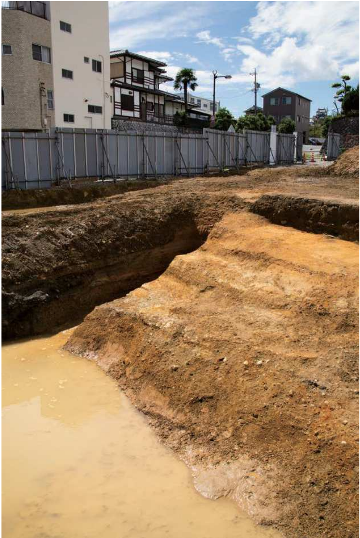
40 次調査区 2 全景（北東から）
