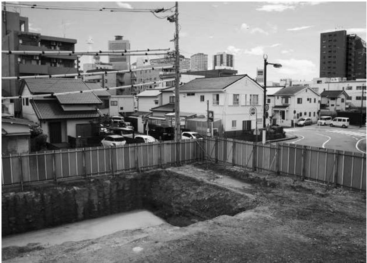
4 調査区2 完掘状況（北西から）
