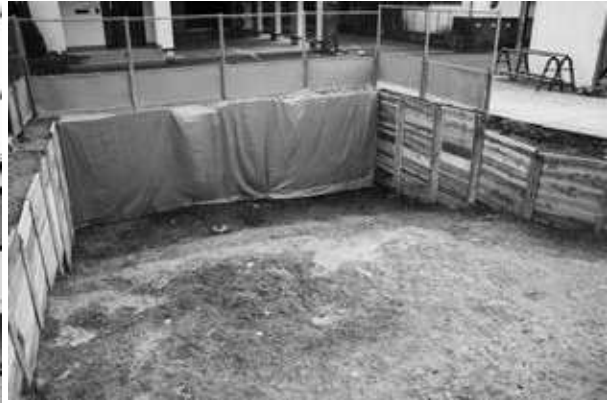
2 調査区1 完掘状況（北西から）
