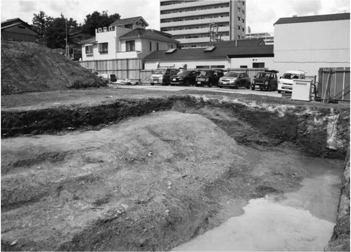
1 調査区2 完掘状況（南東から）
