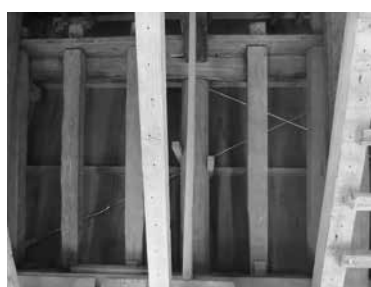
天井裏 鋼製ブレース
