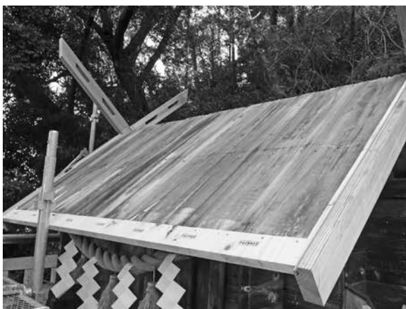
修理中 下地板・破風板・千木・軒先の取替と嵌木（左 前面 右 背面）
