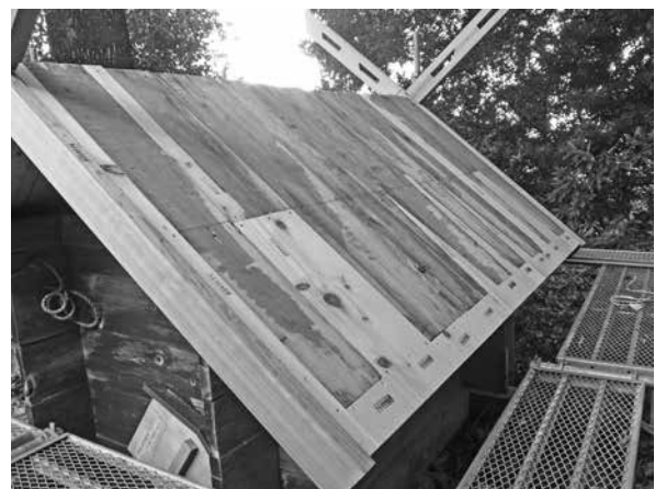
修理中 下地板・破風板・千木・軒先の取替と嵌木（左 前面 右 背面）
