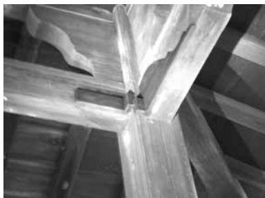
横架材 接合部補強（抜け防止）
