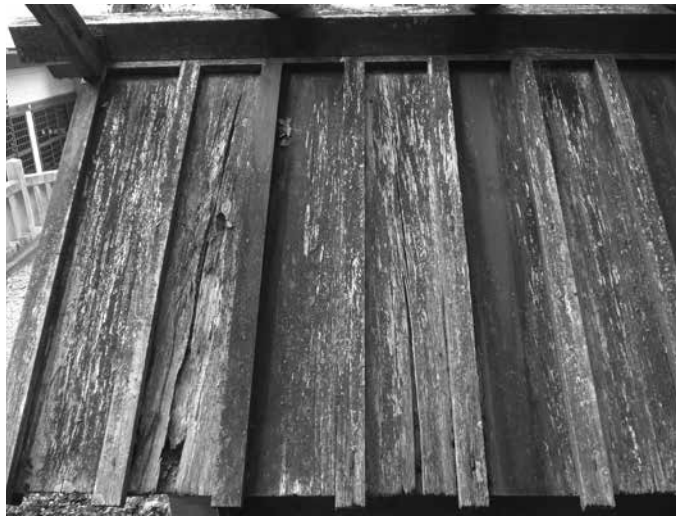
修理前 屋根板の腐朽（背面）
