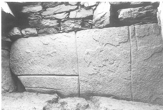
3. 玄室左側壁状況（右側壁より）
