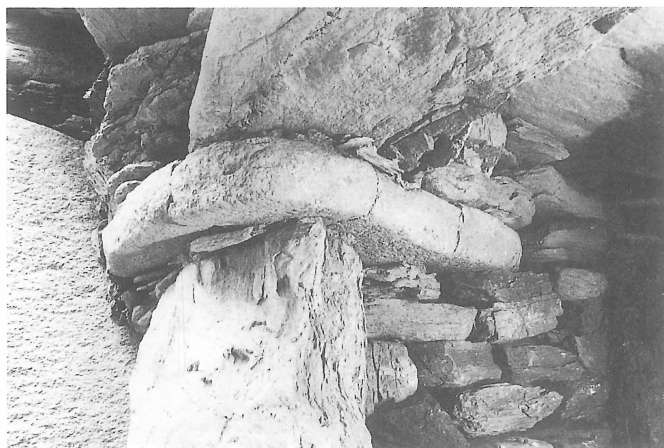
7. 右袖石上部状況（玄室より）
