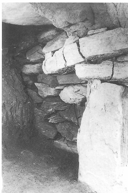
2. 羨道部（前室）左側壁 石積状況
