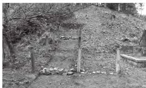
完了後 近景 (北から)
