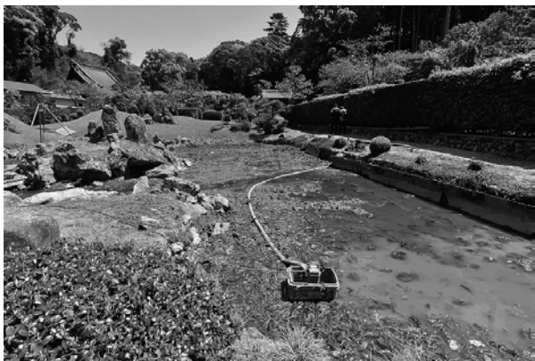
浚渫（西側から）
