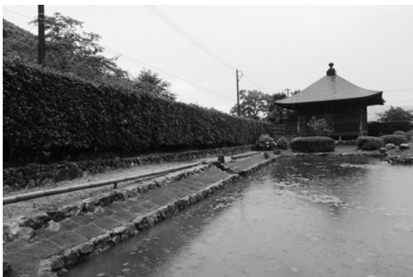
修理後 南側護岸（北東側から）
