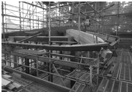
実相寺庚申堂保存修理工事の様子
