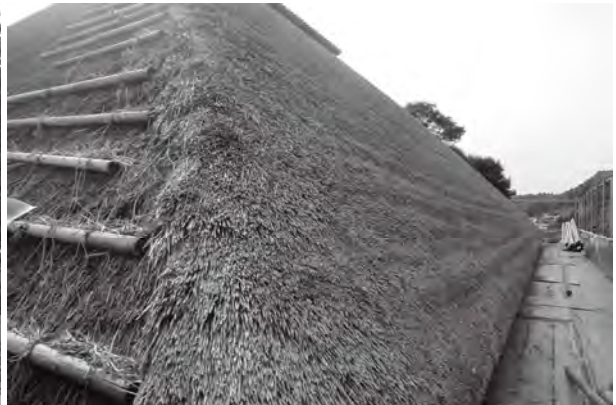
施工中 差し茅 北東面
