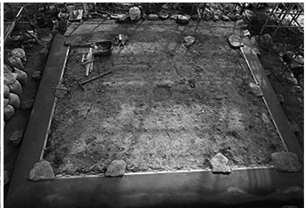
実相寺庚申堂 解体完了後
