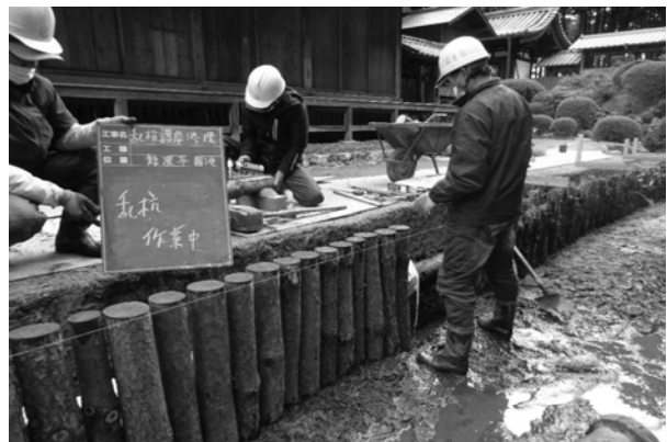
乱杭（丸太杭）の設置作業
