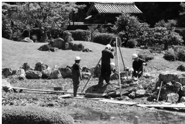
蓬莱出島の石組の修理作業
