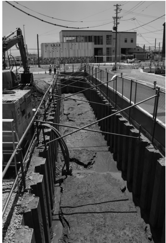
調査区完掘状況 (北から)
