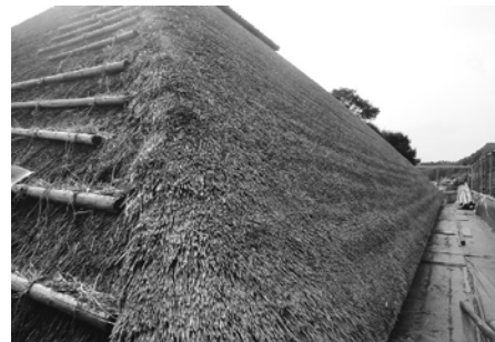
宝林寺方丈保存修理工事の様子
