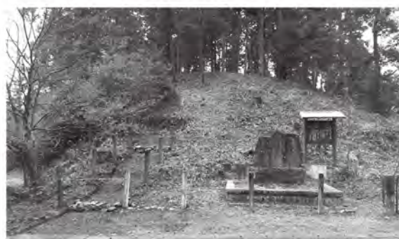
完了後 全景 (北から)
