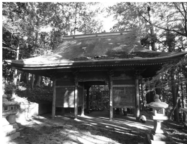
施工前 全景 西面
