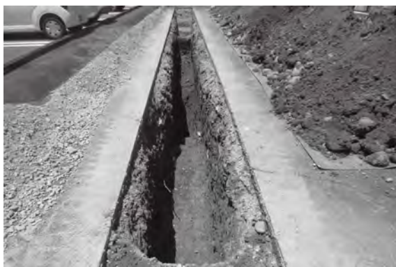
調査溝 2 完掘状況
