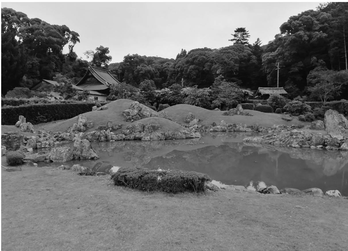
修理後 中央部築山と蓬莱出島（西側から）
