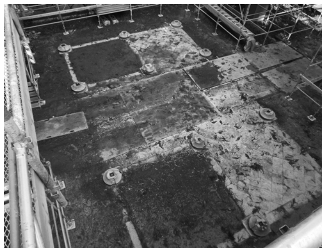
解体状況 2階足場南西より
