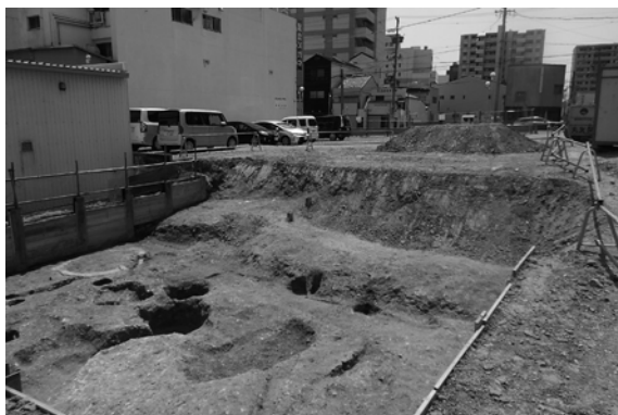
調査区完掘状況 (北西から)
