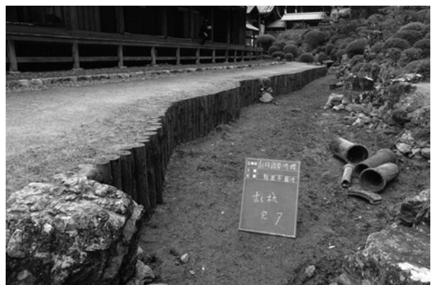
乱杭（丸太杭） 設置完了
