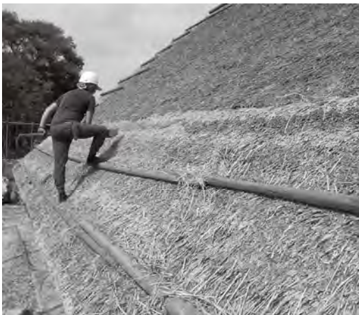
施工中 差し茅 正面
