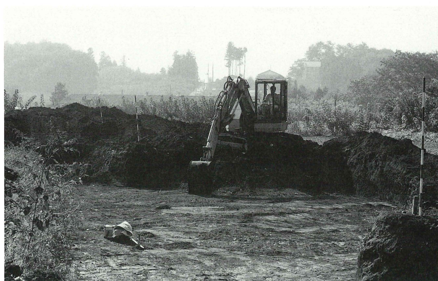
重機による表土掘削
