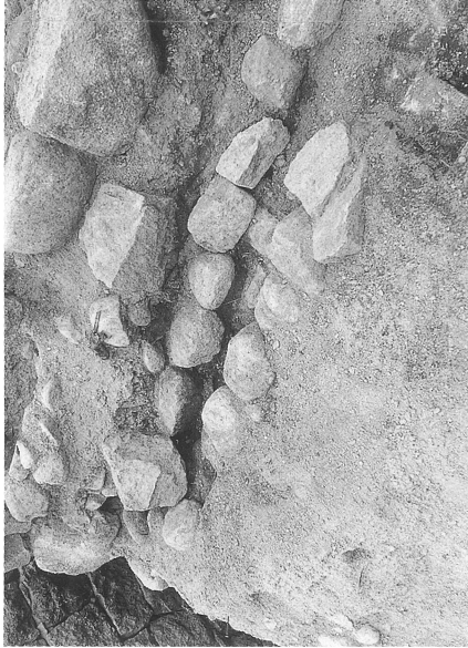
第48図 東側半地下遺構第1面の石組暗渠検出状況 (南東から)
