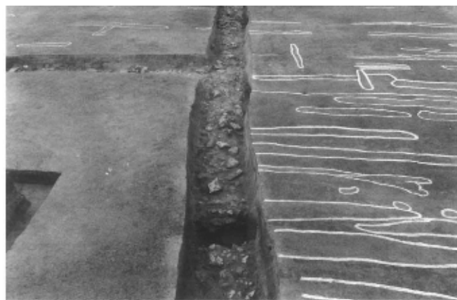
II区暗渠北半上面検出状態（東から）
