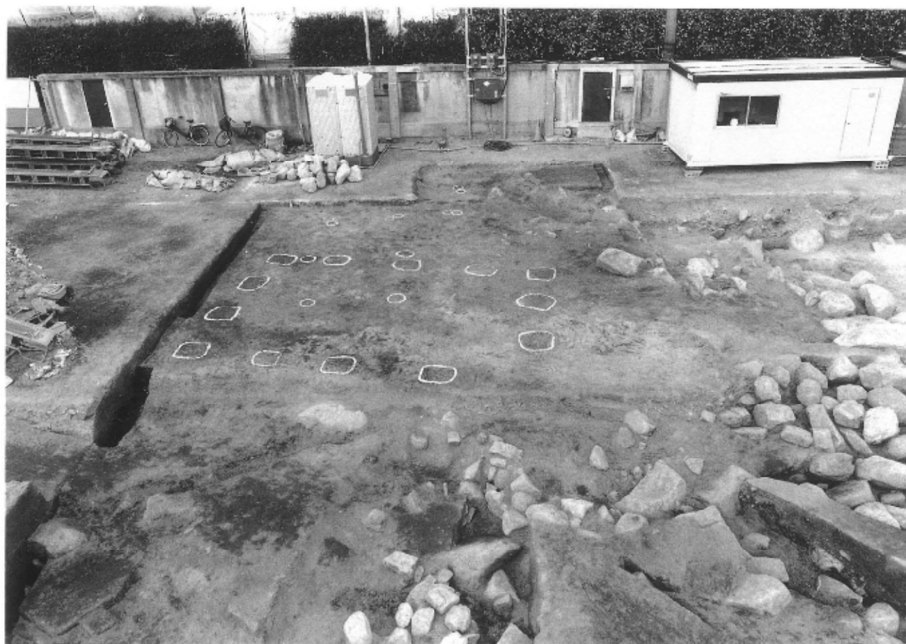
掘立柱建物 SB 1 上面検出状況（南から）
