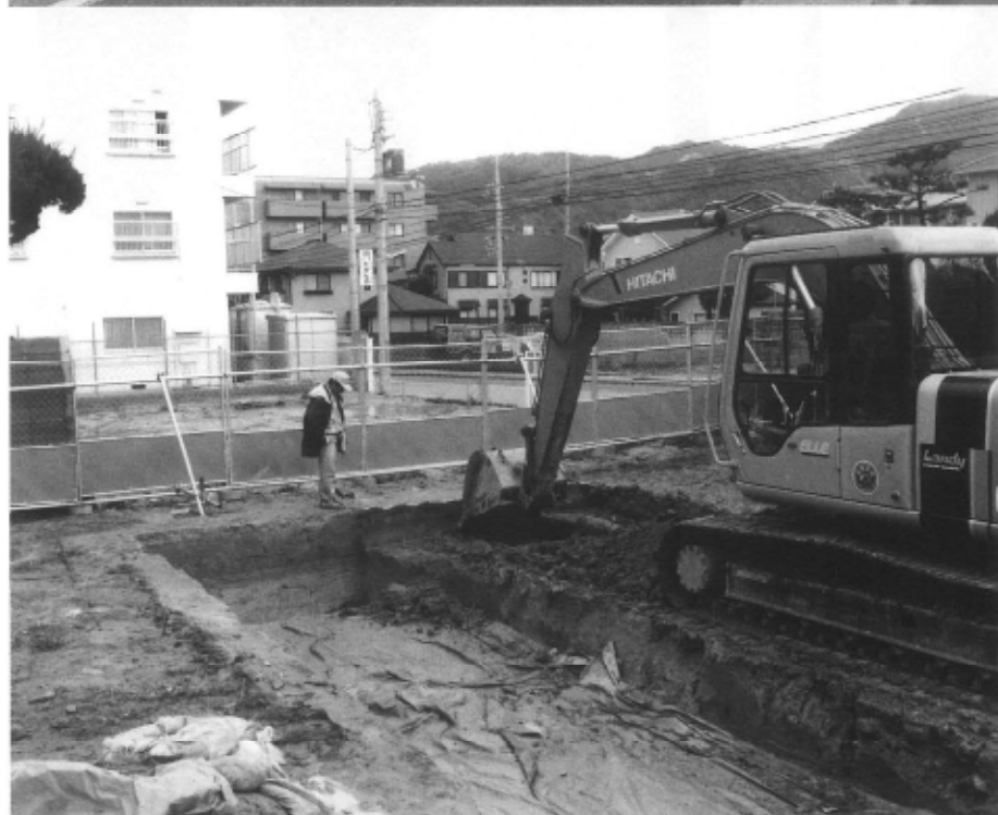
発掘区重機掘削状況 （南西から）
