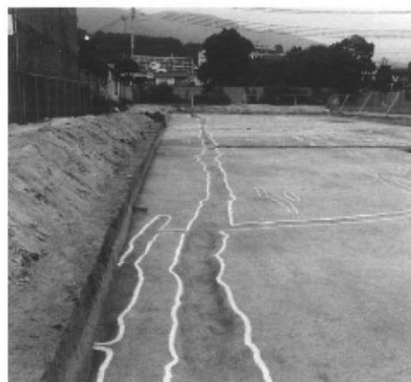
II区3号溝掘削状態（南から）
