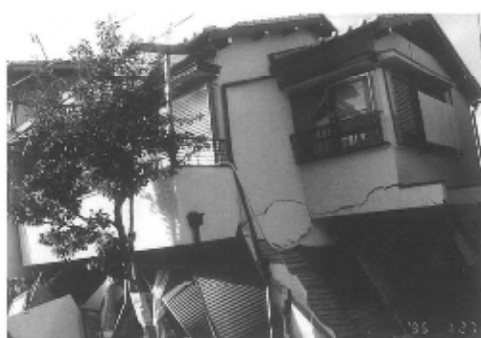
第15図 被災した民家〔市内津知町付近〕 (1995年1月27日撮影)
