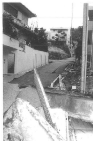
第18図 芦屋市三条町付近の被災状況 (1995年2月9日撮影)
