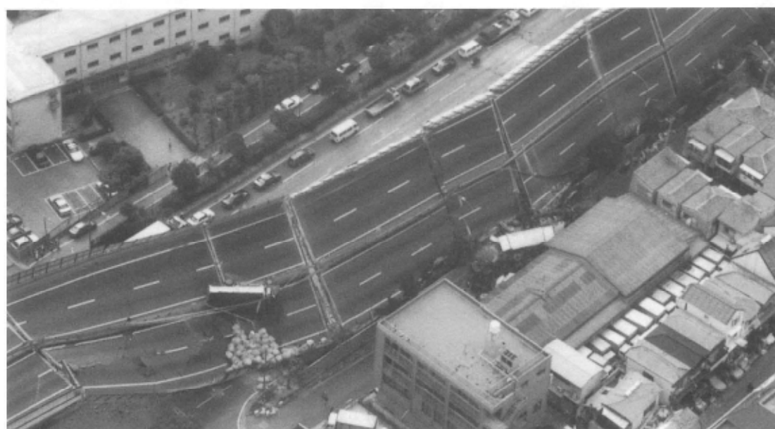
第 8 図 阪神・淡路大震災による阪神高速道路倒壊状況近景 （平成 7 年 1 月 17 日撮影・アジア航測株式会社 提供）
