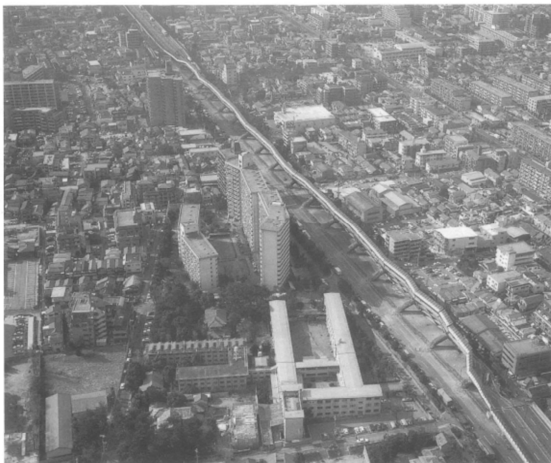
阪神・淡路大震災による阪神高速道路倒壊状況遠景（平成 7 年 1 月 17 日撮影・アジア航測株式会社 提供）
