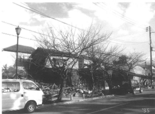
第14図 被災した町並(川西町付近)(1995年1月27日撮影)
