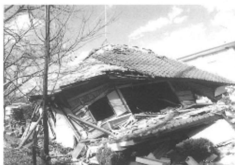
第16図 被災した民家〔市内津知町付近〕 (1995年1月27日撮影)
