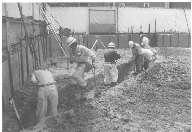
第23図 深基礎掘削時の工事立会状況
