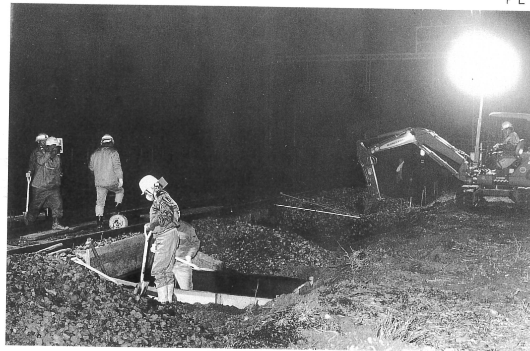
作業風景 (西から)
