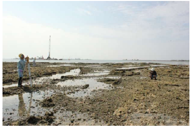
写真 12: 測量作業状況
