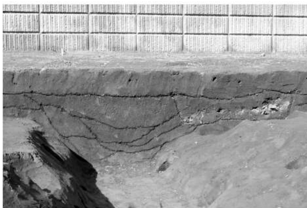
8. N 23 - S D 25 断面D 南から
