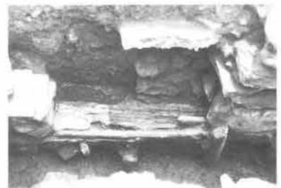
第8図 SD1北端部石垣基礎（西から）
