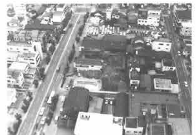
第3図 調査地周辺状況 (東から)
