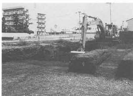
第2図 表土剥ぎ風景（南西から）
