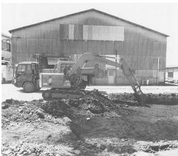
(2)重機による表土剥ぎ風景（東から）
