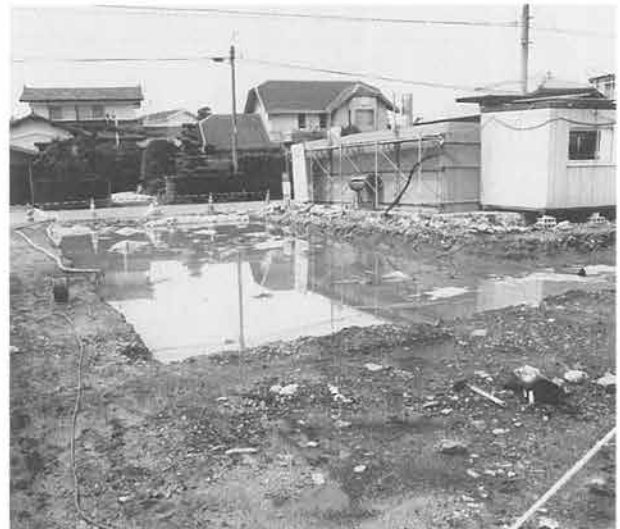
(6) 水没した調査区 (北東から)
