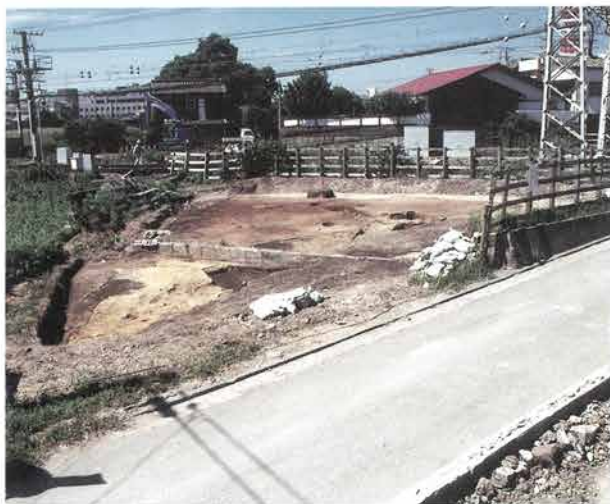
第11図 B区西側全景（東から）
