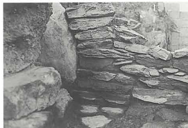
(6) 再構築石室奥壁（南から）
