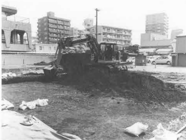
(5) 重機による表土剥ぎ (西から)
