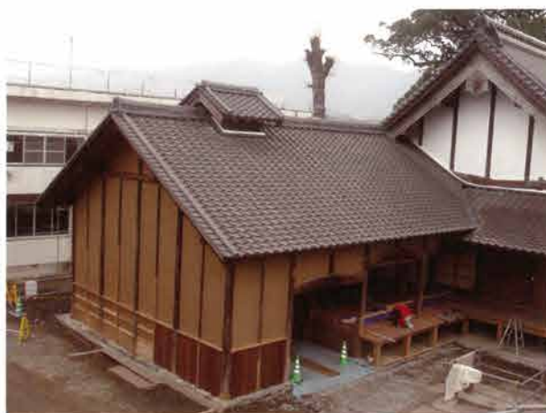
第10図 再組立中の釜屋（北東から）
