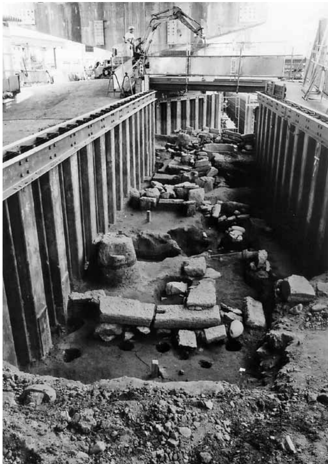
(1) 3面全景（東より）
