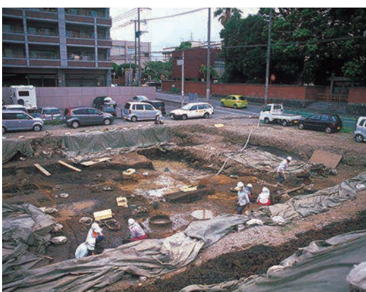
第26図 調査風景（南東から）
