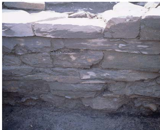
第30図 SD 1 西側石組状況（東から）
