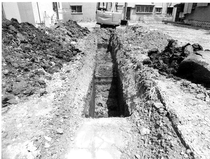
1 越中国府関連遺跡 山森地区 第1トレンチ全景（南）
