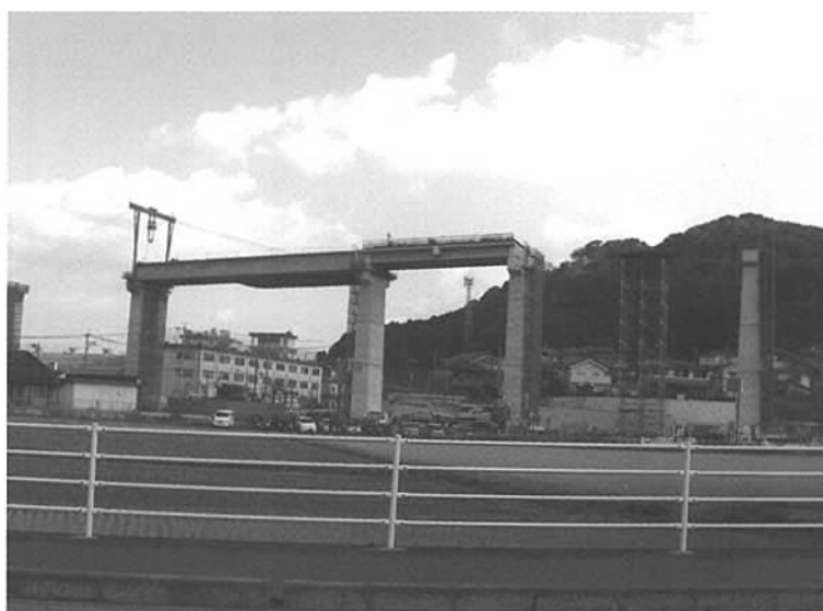
工事風景（那珂川町大字松木地内）
