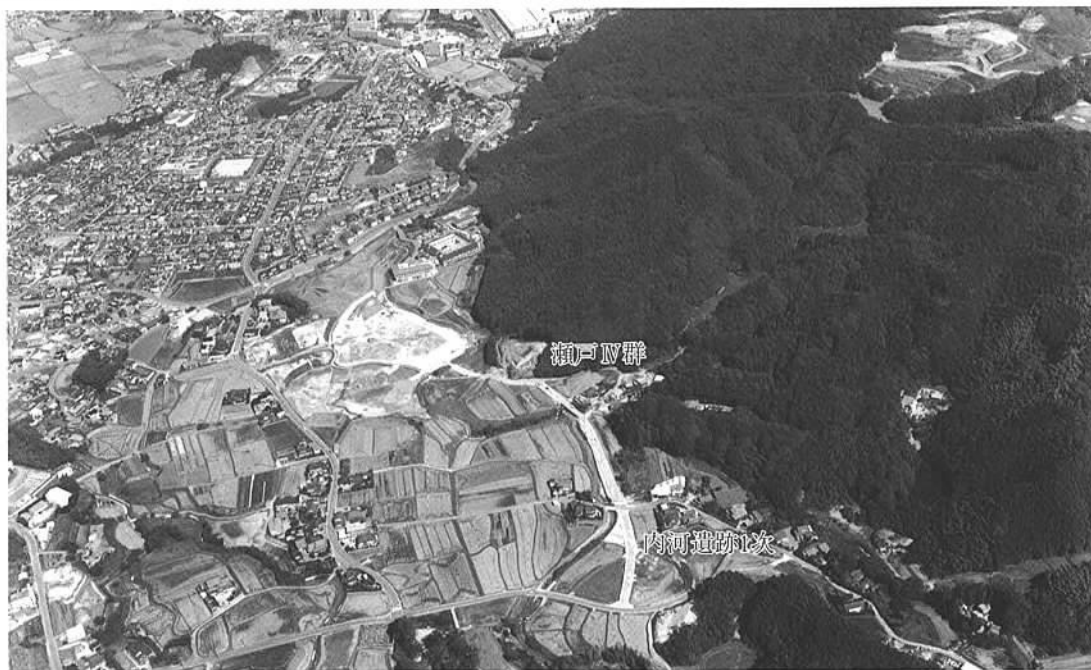
1.瀬戸Ⅳ群 遠景(南から)
