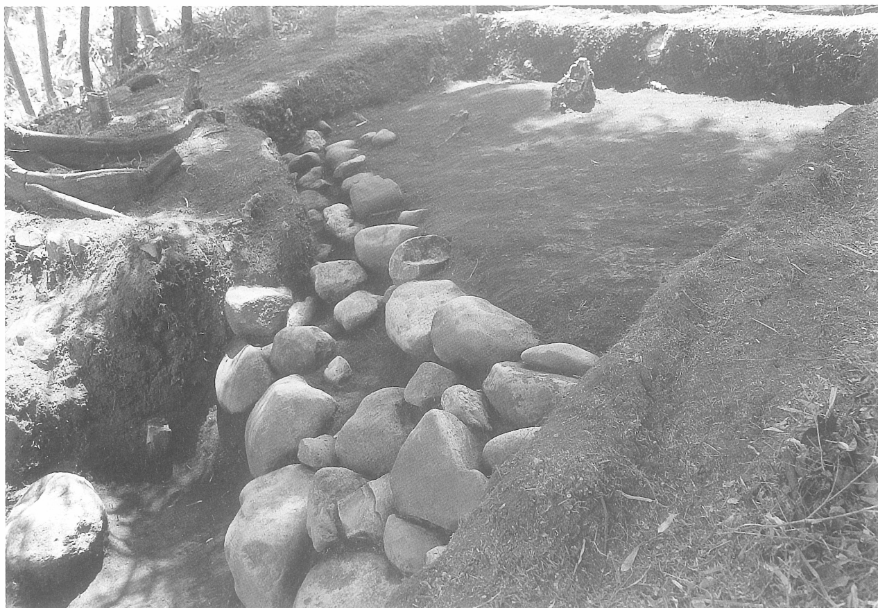
1 丸山古墳 5番トレンチ葺石検出状況 (北より)
