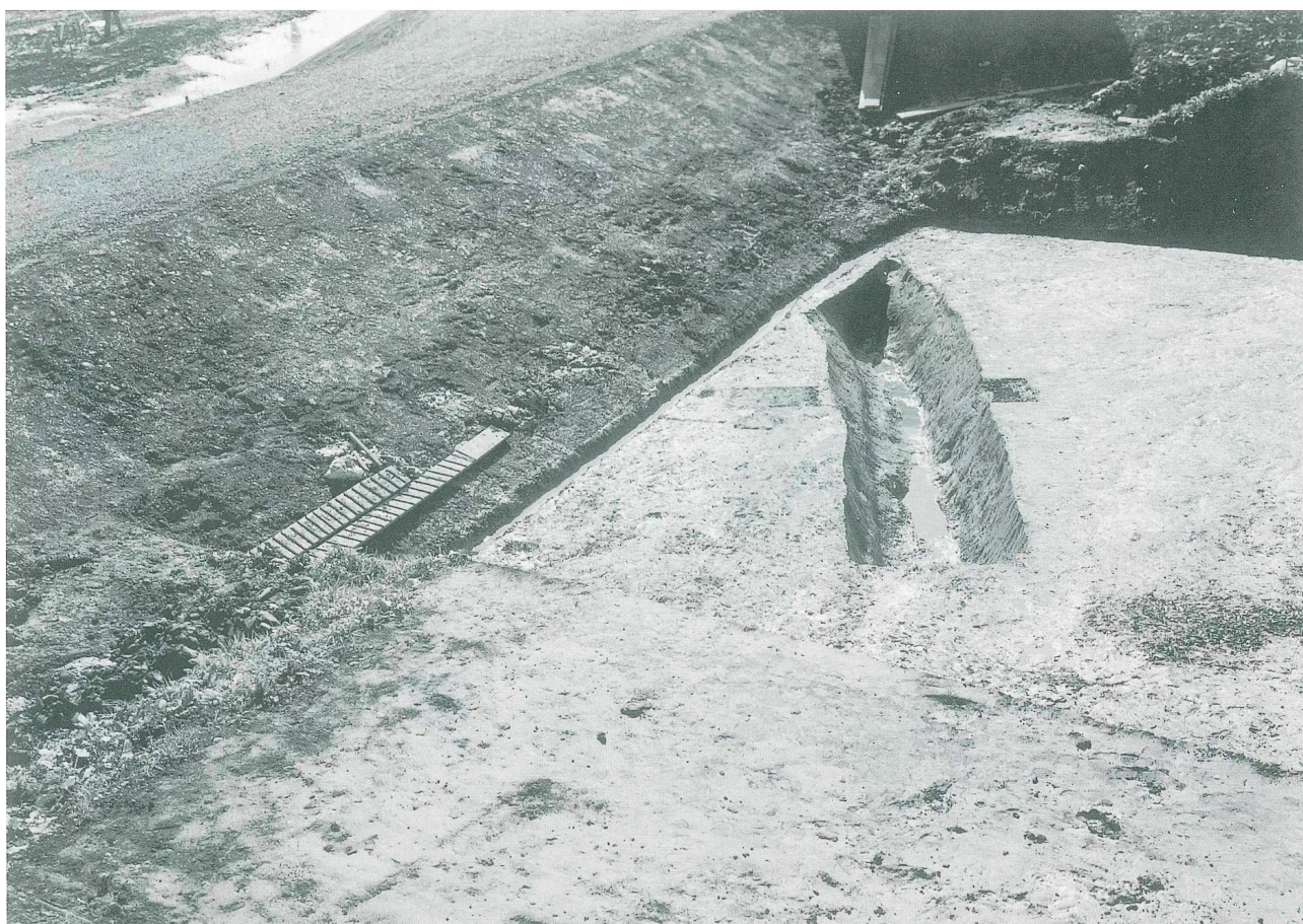
(2) 堤防下全景（北東方より）
