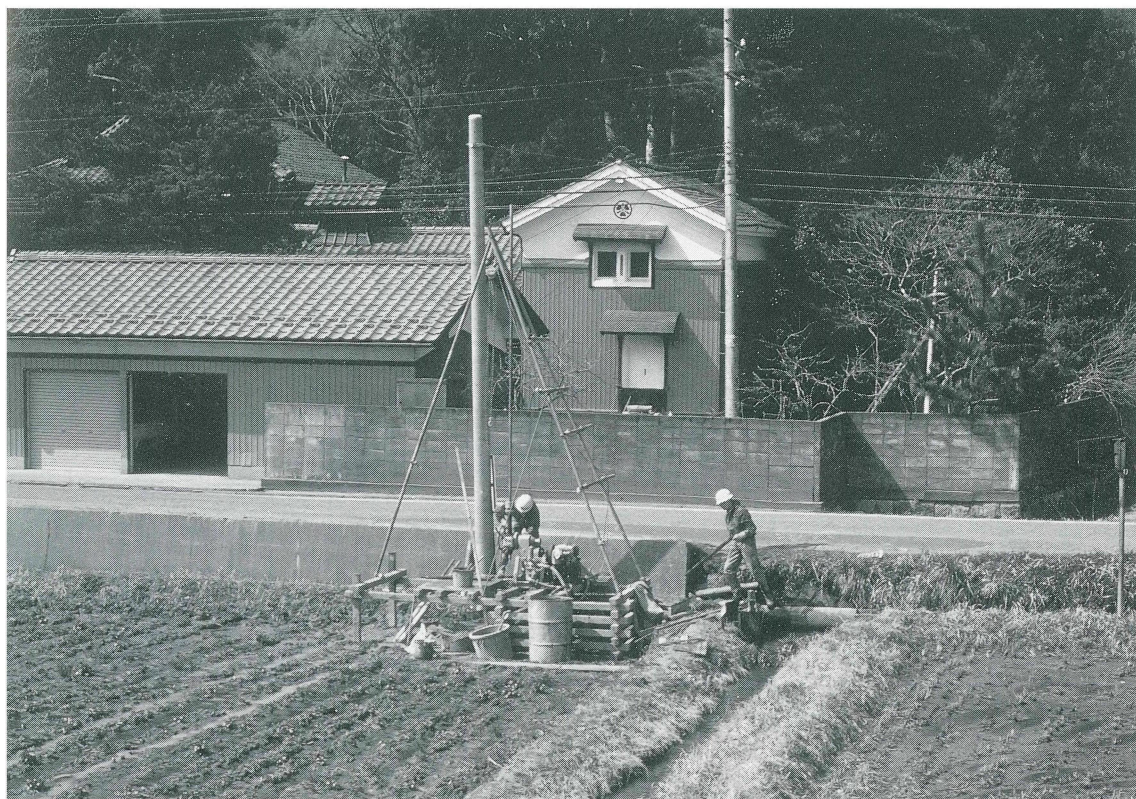
(2)ボーリング調査実施状況(東方より)
