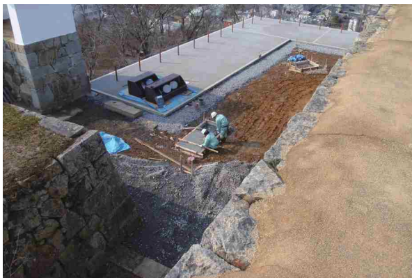
照明器具基礎コンクリート打設
