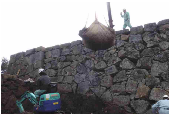
堆積土砂撤去
