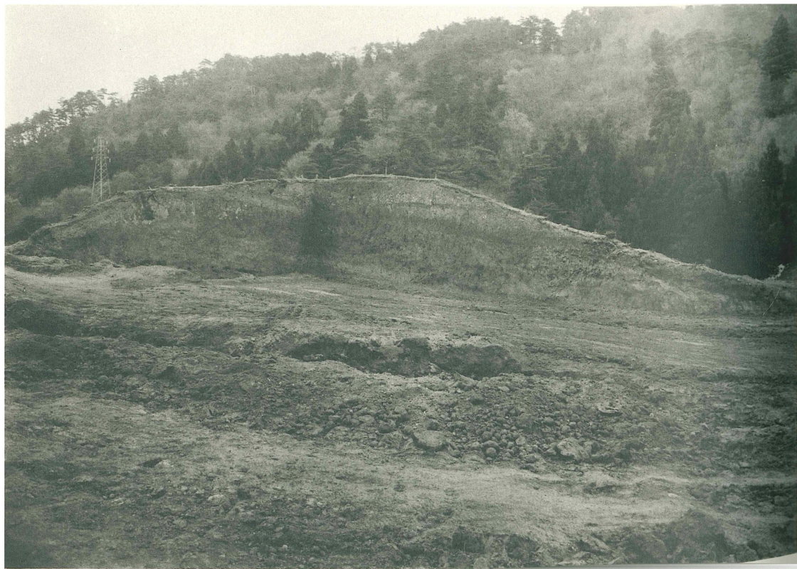
2 39号墳 墳丘断面（西から）
