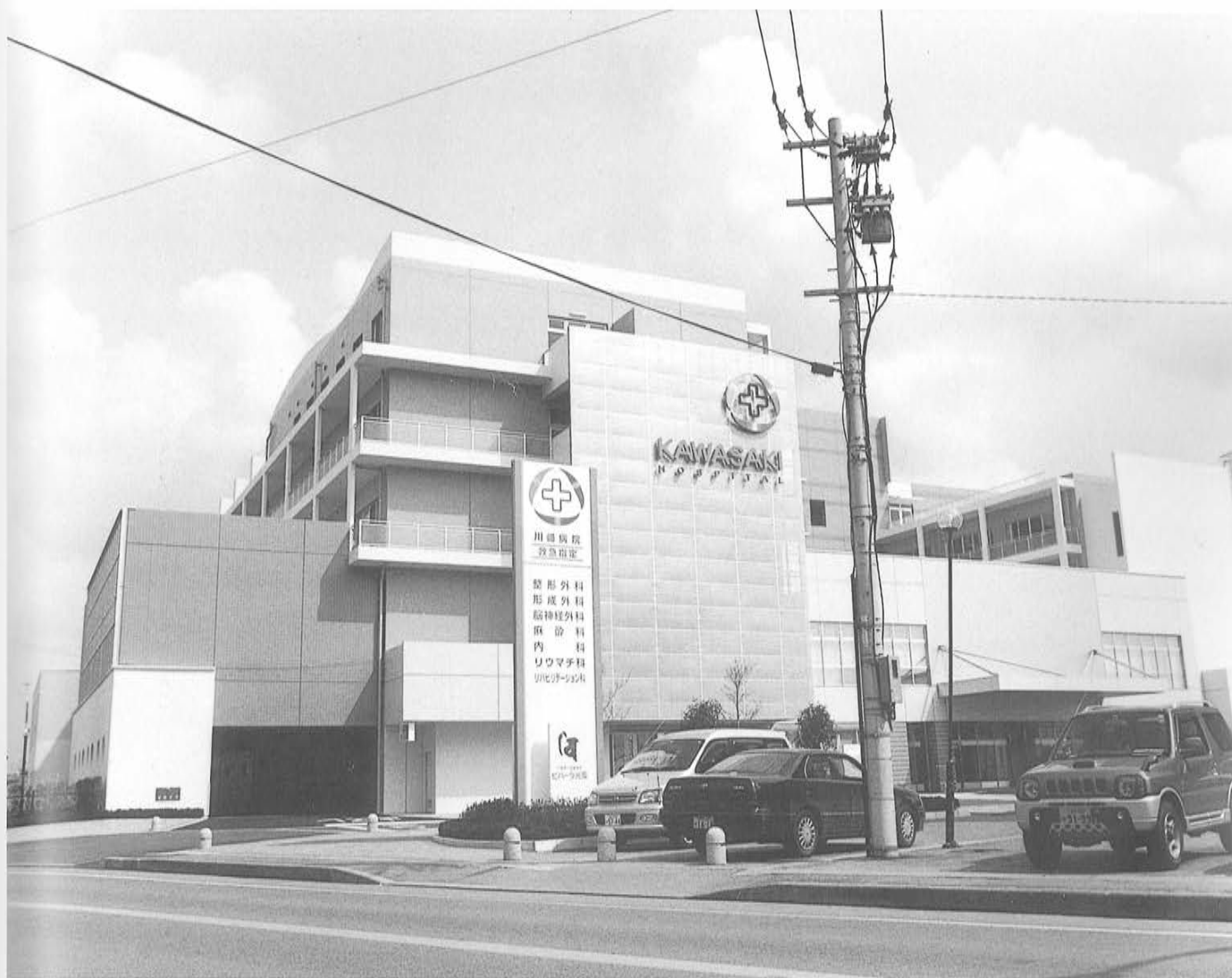
完成間近の新病棟 (高島遺跡 2 次調査地点)
