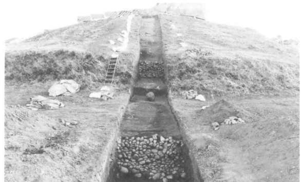
後円部墳丘北東側調査状況 (12トレンチ)
