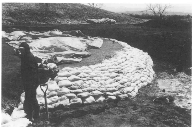
埋め戻し作業（葺石は土嚢で養生）
