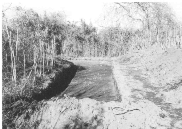
写 32 5トレンチ全景 南から
