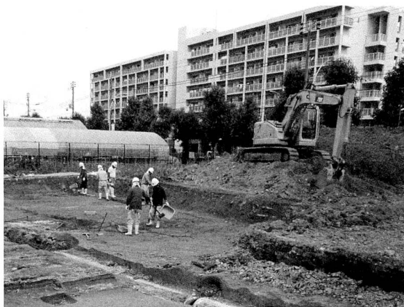
写真1 重機による掘削
