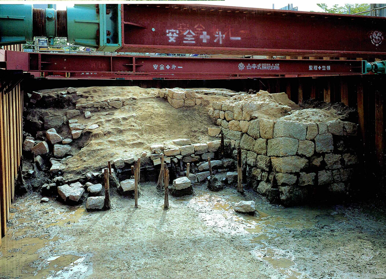
写真2 西側石垣(東から) 3 m近い高さが残ってい た。西岸の石垣は1辺60～ 80cm程の石を積み上げてい る。最下段の石の下には胴 木はなく、そのまま第1石 を据えている。
