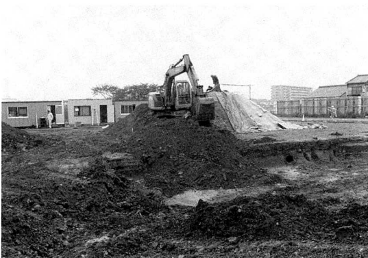
写真3 重機による埋戻し作業
