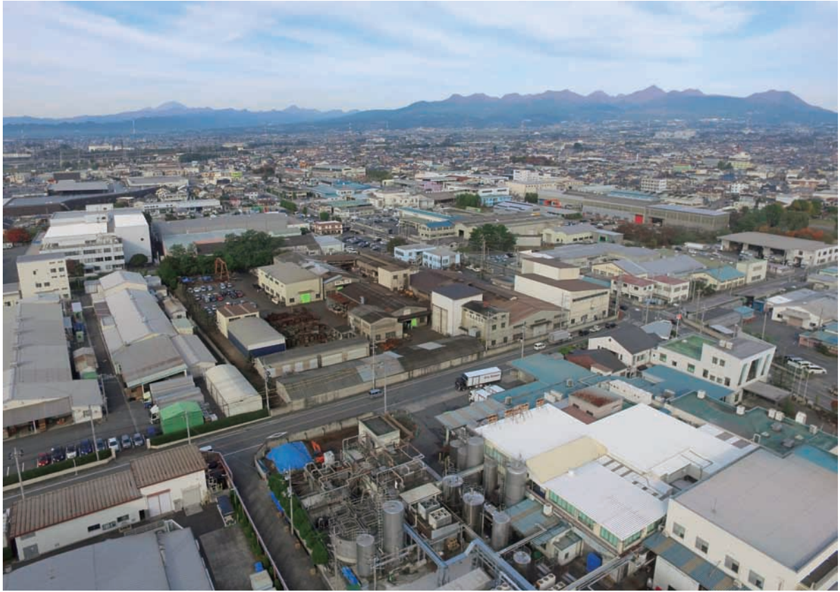
小八木葉研寺遺跡遠景（南東から）
