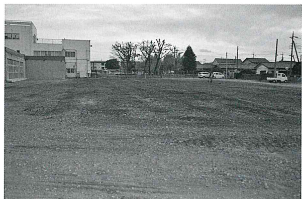
埋め戻し終了状況 (北から)
