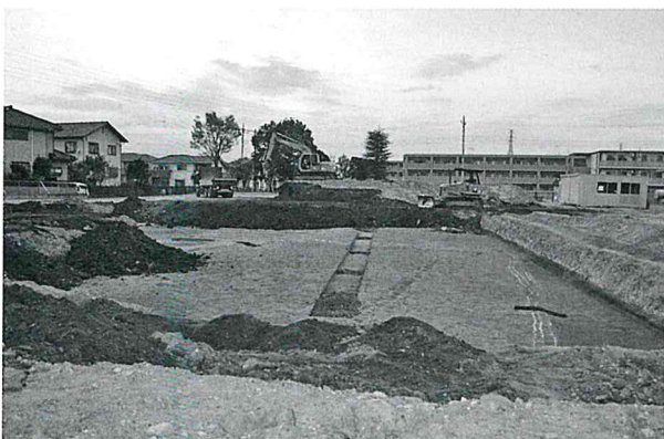
埋め戻し作業 (南から)
