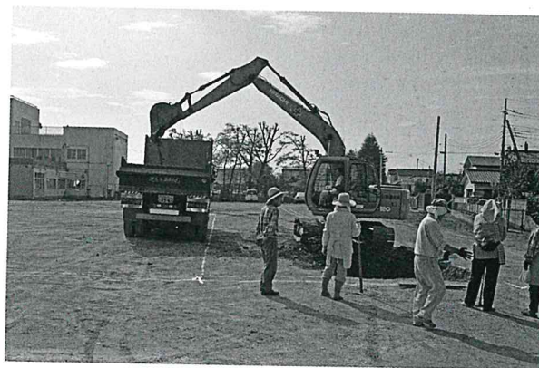
掘削作業開始状況 (北から)
