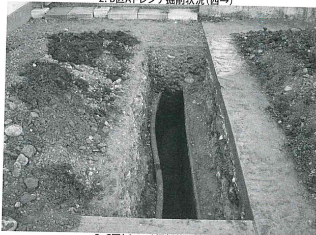
3. C区トレンチ掘削状況(南→)
