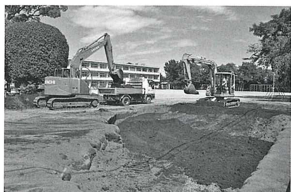
埋め戻し作業 (西南から)
