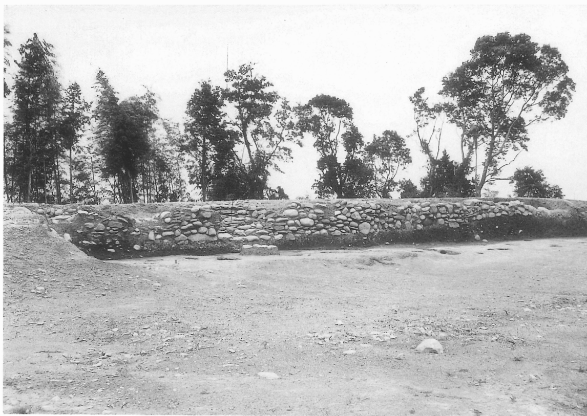
第34図 1号建物・石垣
