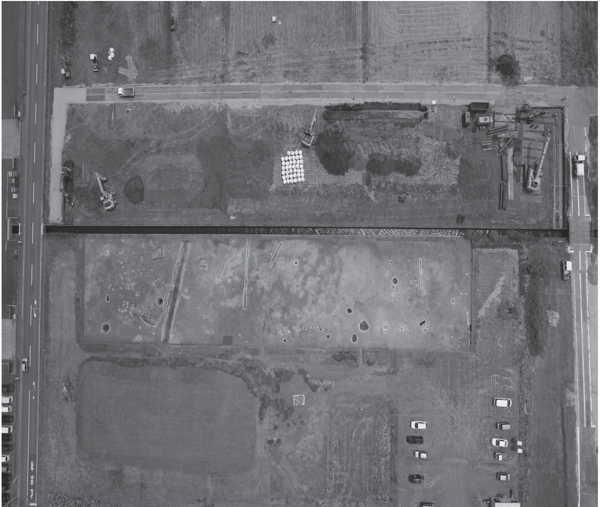
調査区全景 俯瞰
