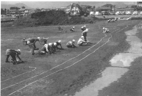
作業風景（南東から）
