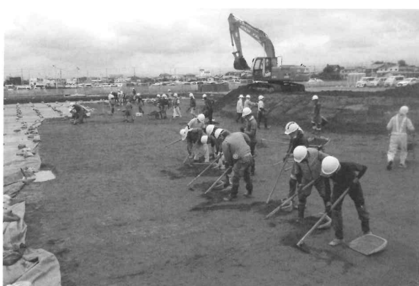
作業風景（東から）
