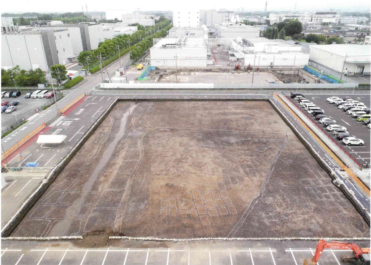
Hr-FA洪水層下水田全景（北から）
