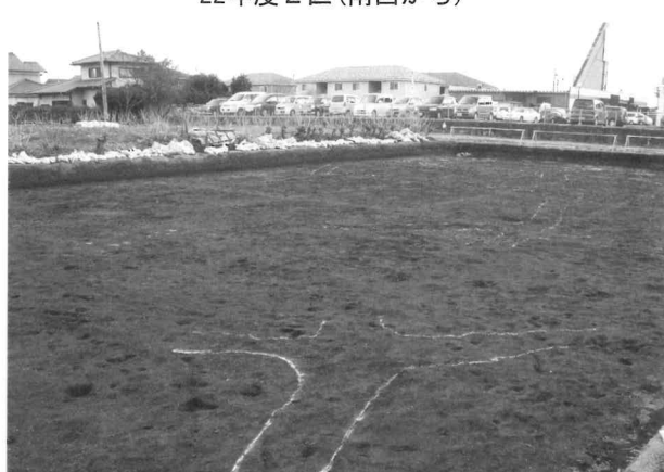
23年度調査区(北西から)
