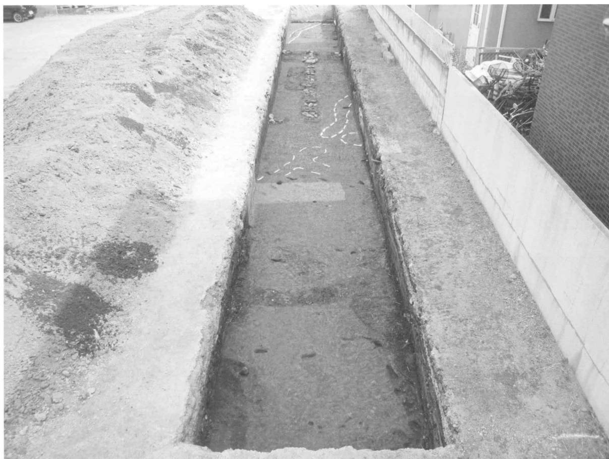
A区 全景 (西から)
