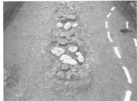
土蔵跡杭基礎 検出状況 (西から)
