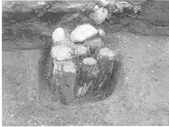
杭基礎 露出状況 (南から)
