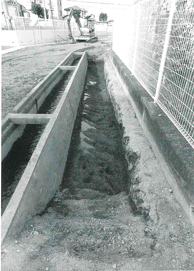
A区第3面東半完掘状況全景(東→)
