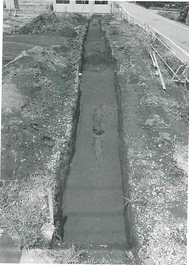
A区第1面完掘状況全景(南→)
