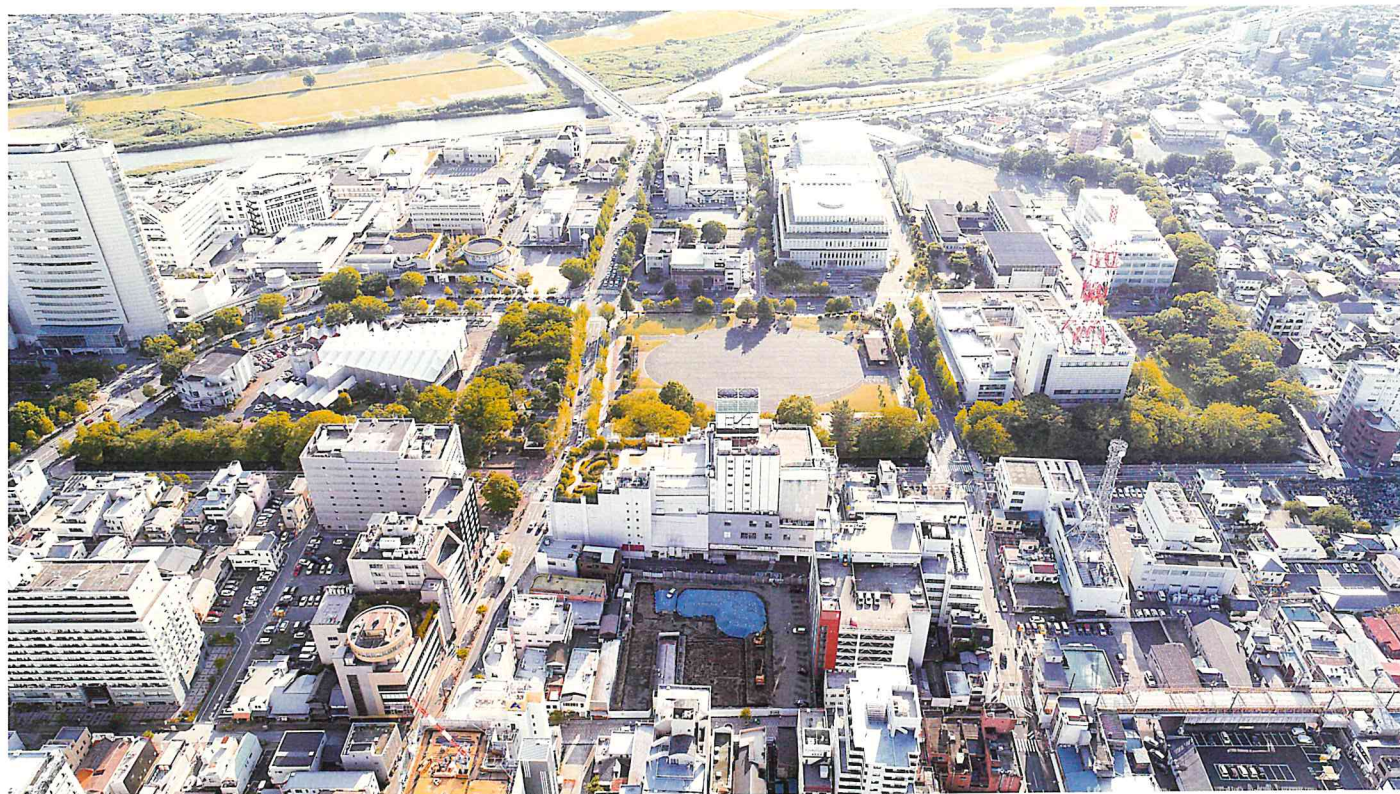
調査区上空から見た高崎城（東から）
