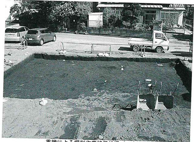
重機による掘削作業終了状況 (→南)
