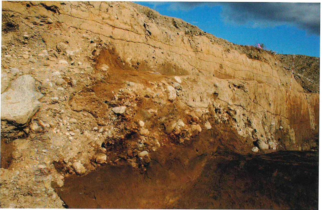
SD-6 土層断面 (C区)
