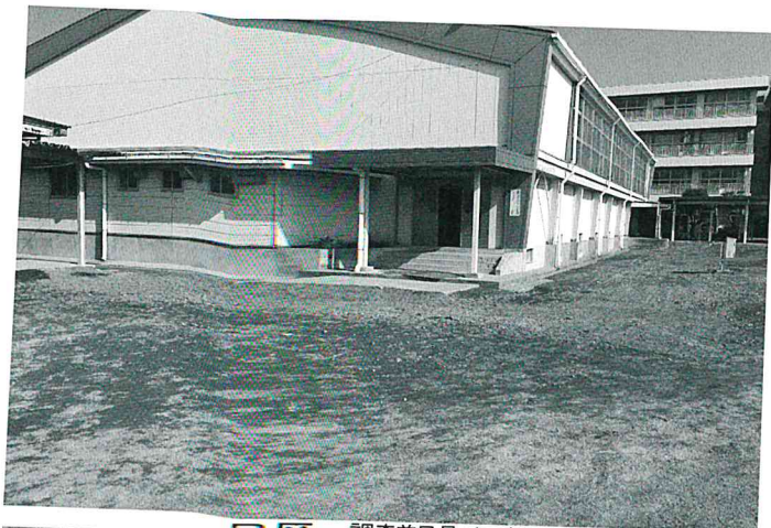
B区 調査前風景 (→南)
