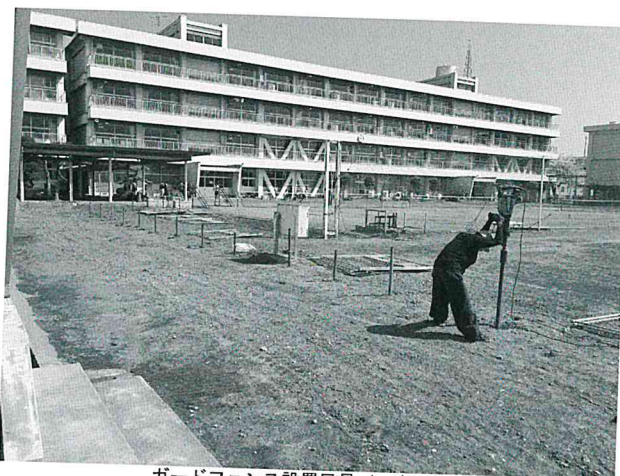
ガードフェンス設置風景 (→南西)
