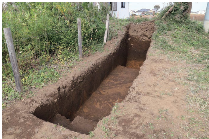
2 1トレンチ 南東から
