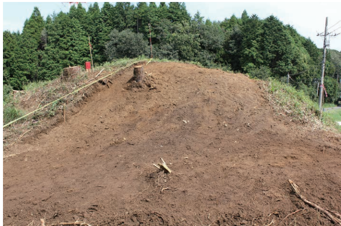
1 (1)SX001 表層除去状況 南から
