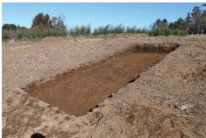
5 (4) 6トレンチ 南から
