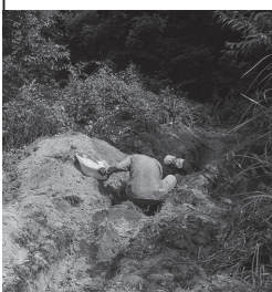
唐松A 掘削状況
