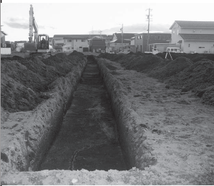
掘削・遺構検出状況
