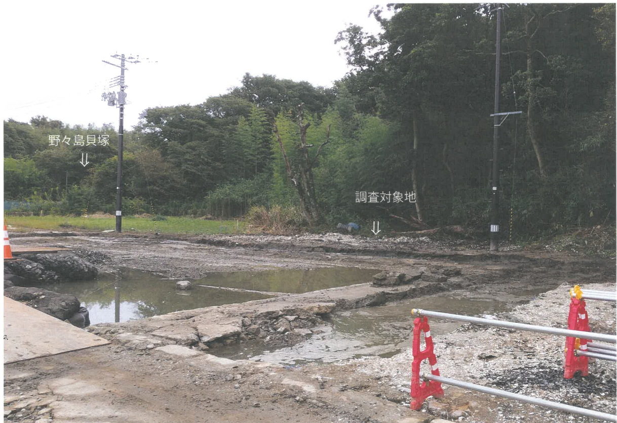
2. T9~T12 調査前の状況（北西から）
