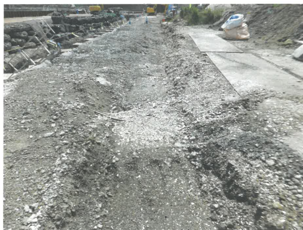
写真8 既存排水溝撤去部（西から）
