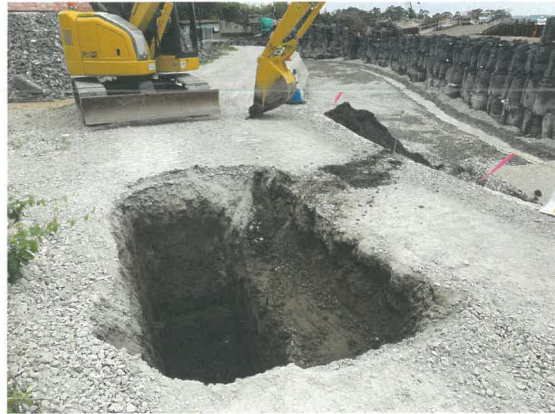
4. T②調査風景（南東から）
