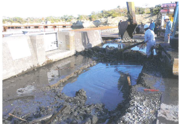
5. T3 の調査状況（西から）
