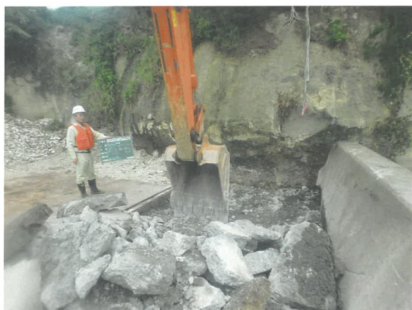
写真7 既存コンクリート撤去部（西端部、東から）
