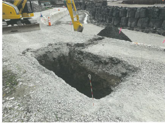
2. T①調査風景（南東から）
