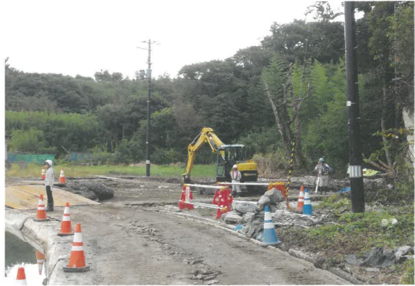
写真3 T9～T12 調査地点 北西から
