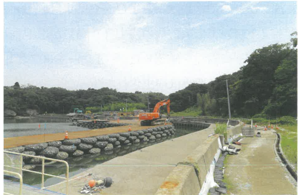
写真4 調査対象地（西から）
