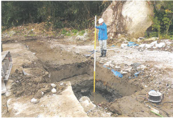
11.T9 (北西から)
