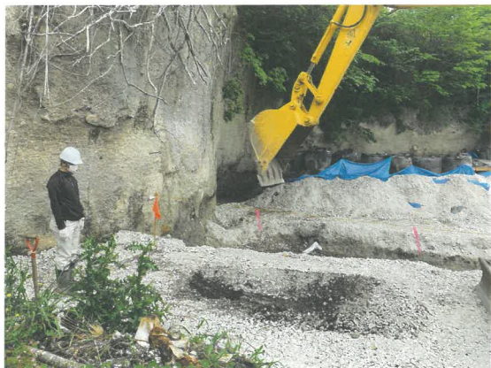
8. T④調査風景（南東から）
