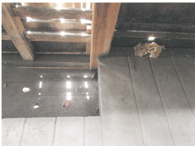
図 31 縁側（切目縁と落縁）
