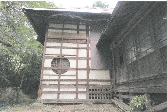
図 48 仮設壁を撤去した東面
