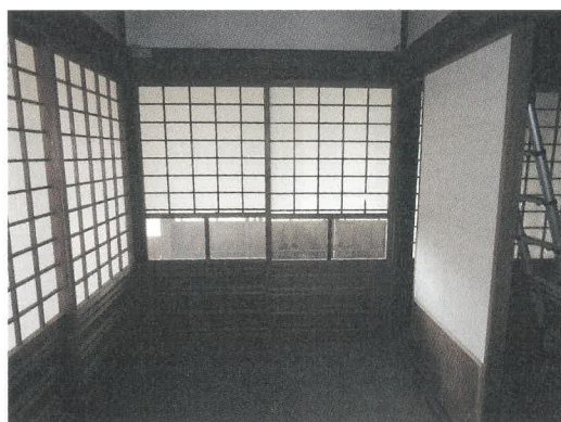
図 30 入側南面の障子（ガラス入り）
