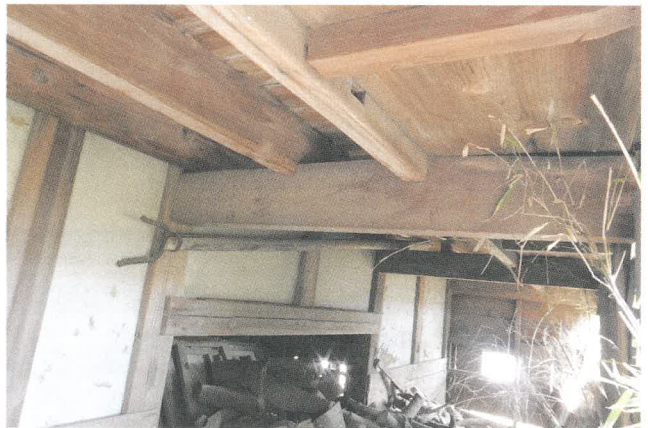
図 19 勝画楼棟縁側床下～段差の下地
