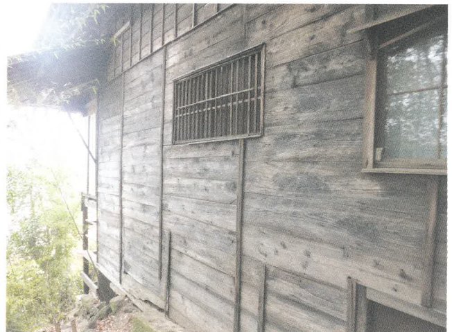
図 24 勝画楼棟北側外壁
