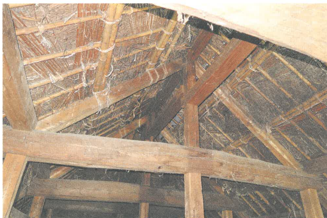
図5 勝画楼棟の小屋裏の状況
