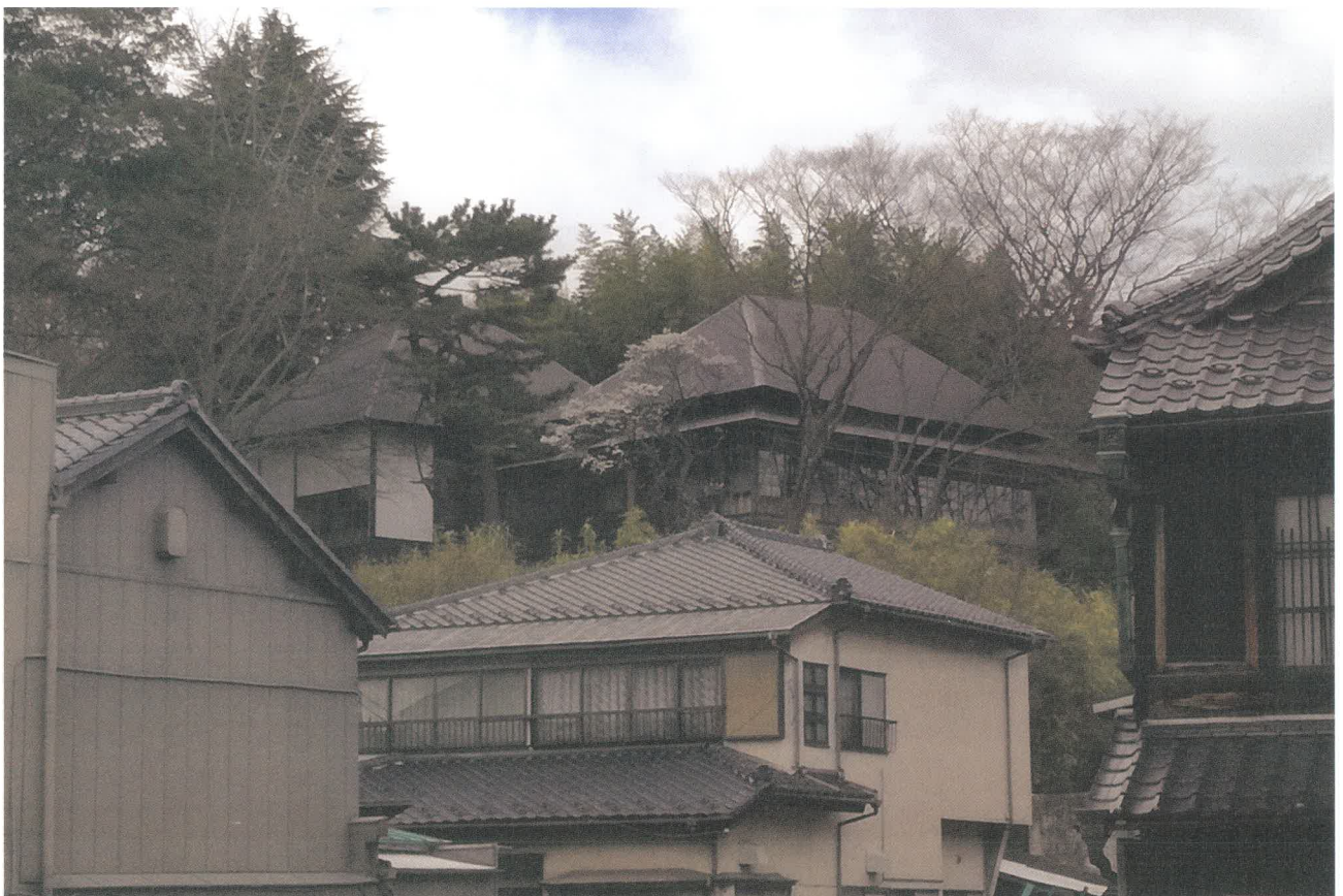
本町方向から勝画楼を望む (応急修繕工事後)
