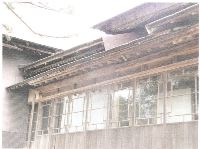
図57 三ノ間屋根（応急修繕工事後）
