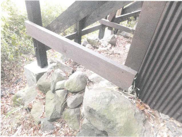
図 23 石積み・束柱修繕箇所 (平成 29 年)
