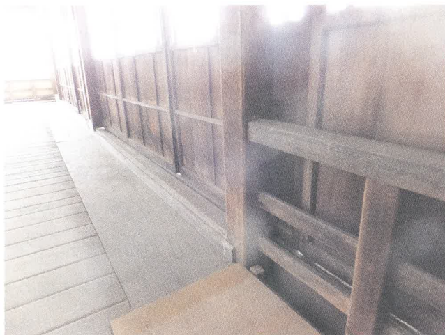
図33 取り外された欄干部
