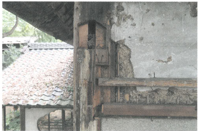
図 49 南西隅柱上部（桁跡）
