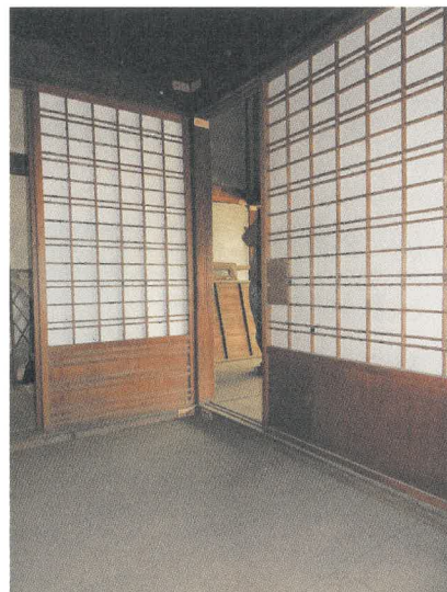
図 29 一ノ間の障子（北東角） 左（北面）：腰・上部とも吹寄棧 右（東面）：上部のみ吹寄棧
