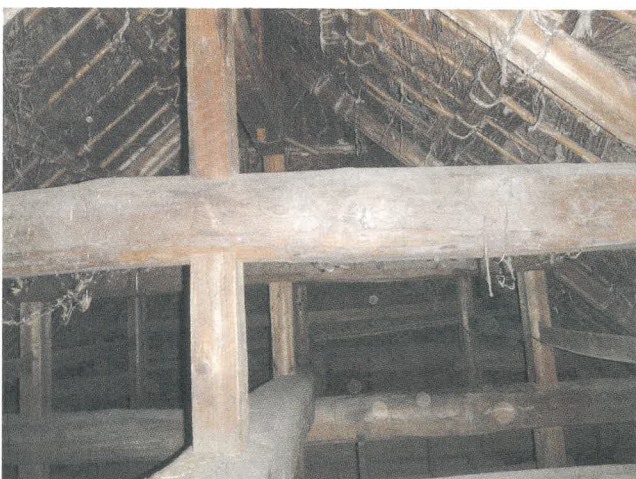
図 27 勝画楼棟小屋裏
