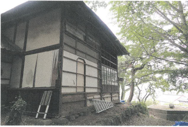
図 46 仮設壁を撤去した南西面
