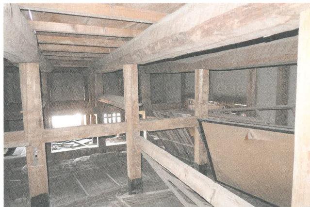
図6 勝画楼棟の床下の状況
