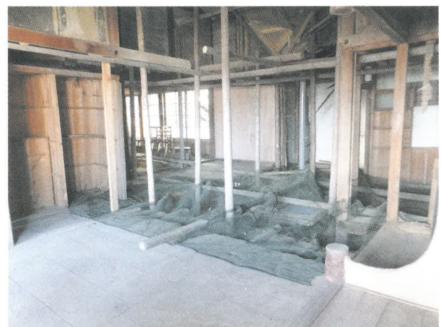
図14 三ノ間～水屋部分のようす(応急修繕工事後)
