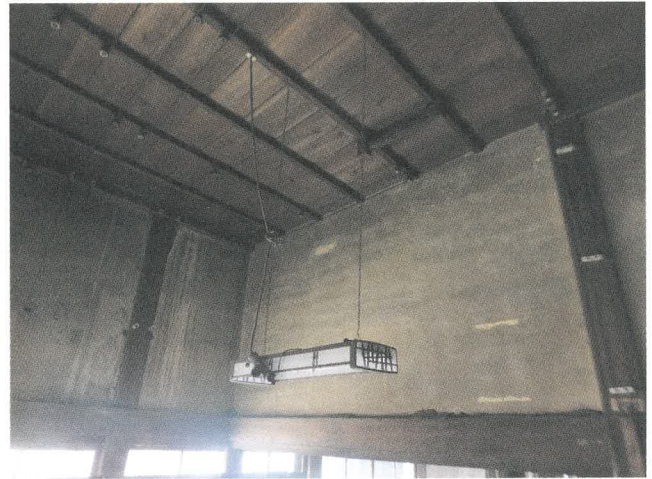
図 41 天井棹縁（右手の小壁が後補）
