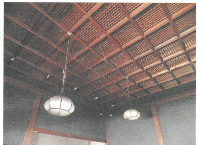
図 26 勝画楼棟一ノ間の小組格天井
