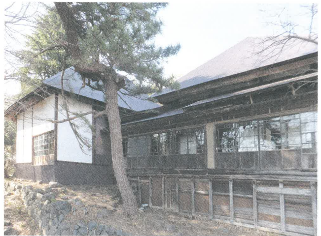
図 55 応急修繕工事完了後の外観
