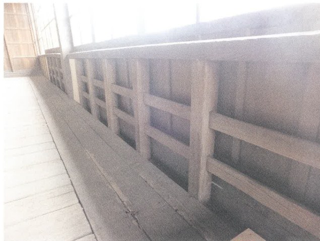
図 32 欄干（勝画楼棟東側）
