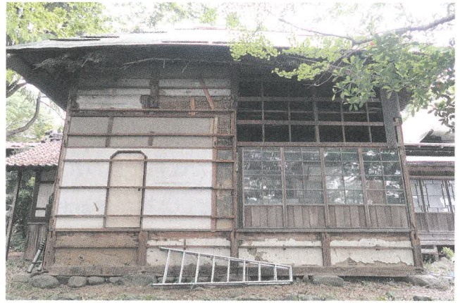
図 47 仮設壁を撤去した南面
