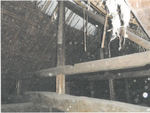
図 40 使用していない仕口跡
